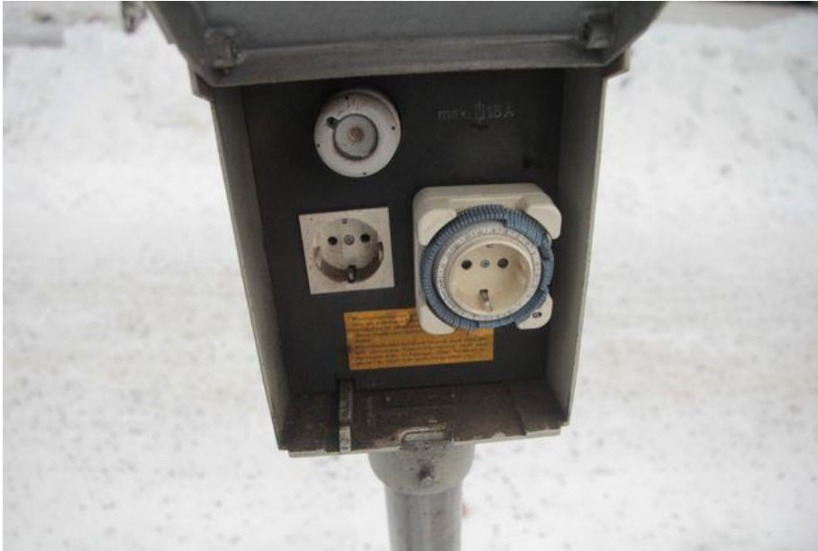
Kuva 24: Lämmitystolppa, jossa toisessa pistokkeessa on asukkaan hankkima kellokytkin (KUVA: Toni Koski 2016)
