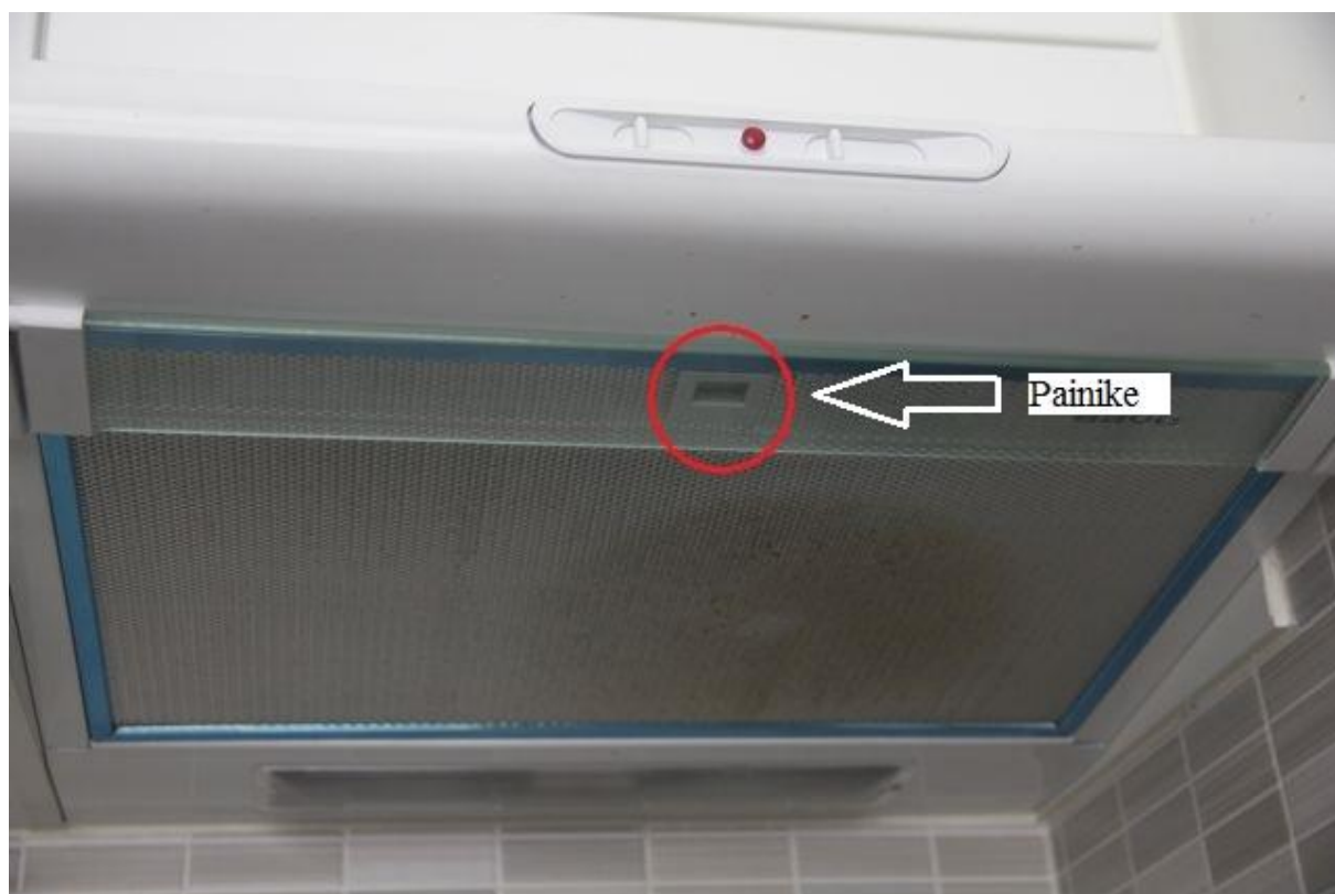
Kuva 20: Rasvasuodatin (KUVA: Toni Koski 2016)
